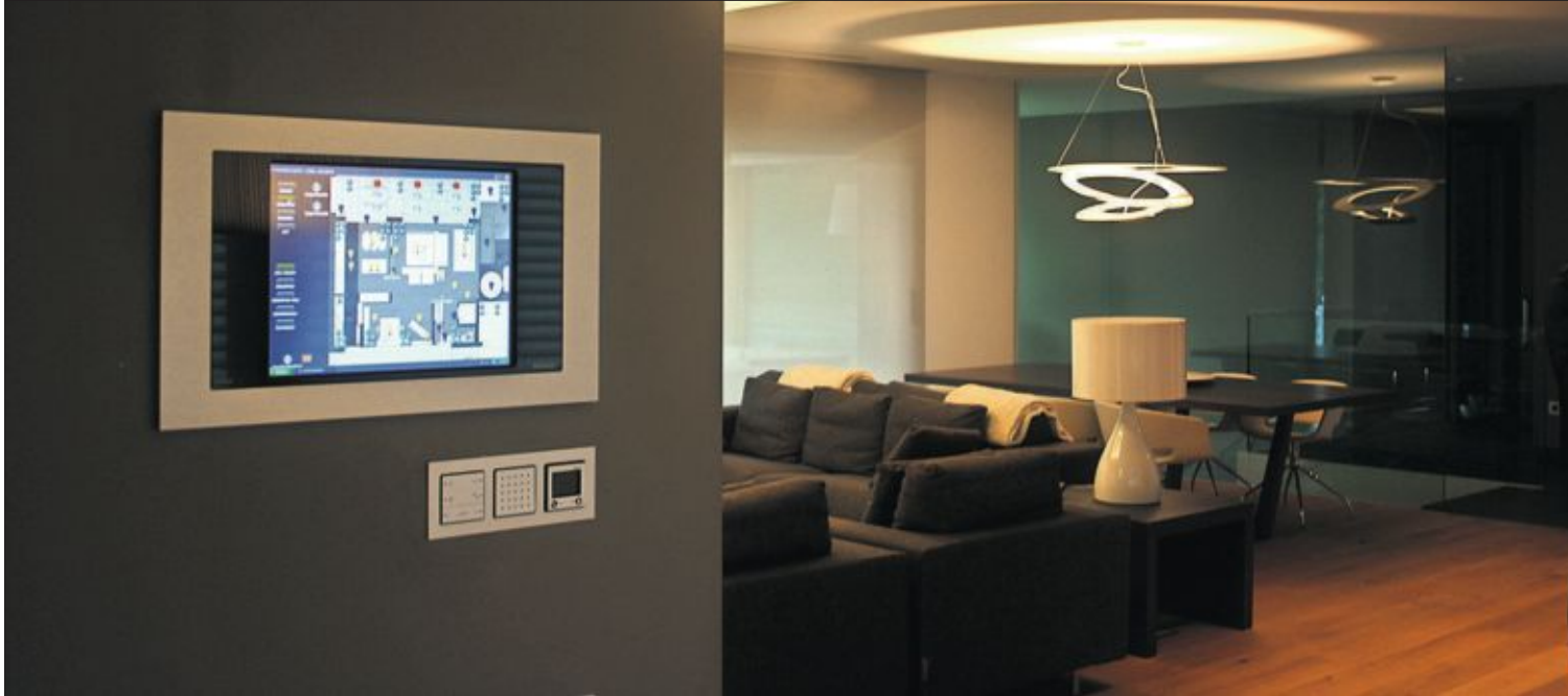
Panel de control domótico de Domintell instalado en el salón desde el que se controlan todos los dispositivos de la vivienda.
